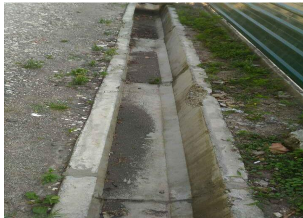
სურათი 2. დაზიანებული სანიაღვრე არხები
