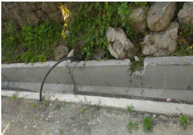
სურათი 2. დაზიანებული სანიაღვრე არხები
